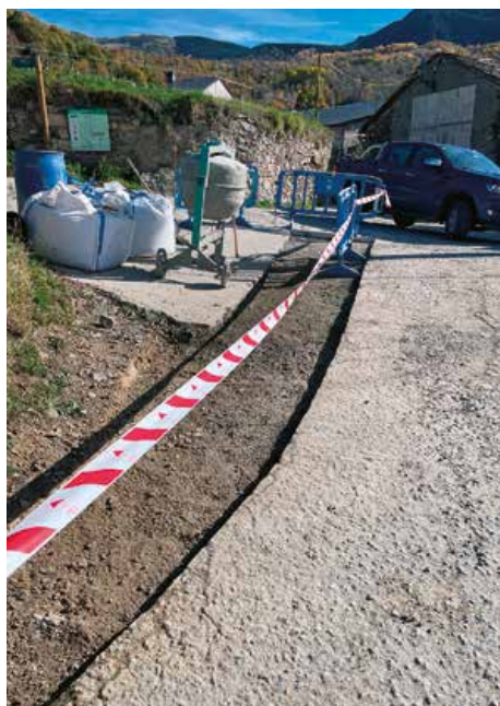
Reparació de formigó en mal estat al poble de Mont-ros
