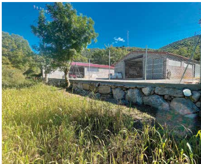
Execució de mur escullera i tanca metàl·lica a les naus de la brigada d'Empalau
