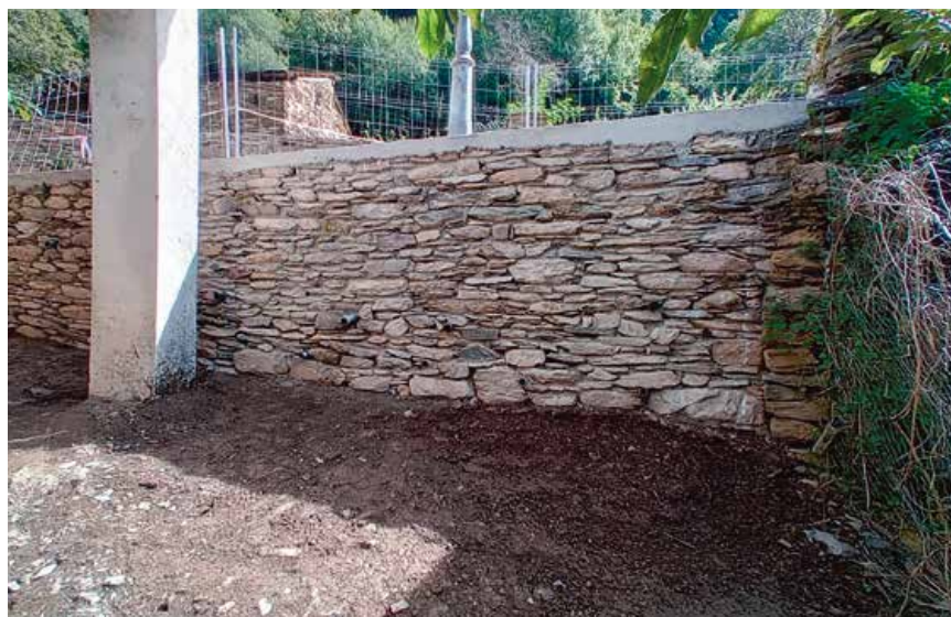
Reparació de mur de pedra esfonsat en un carrer d'Aiguabella
