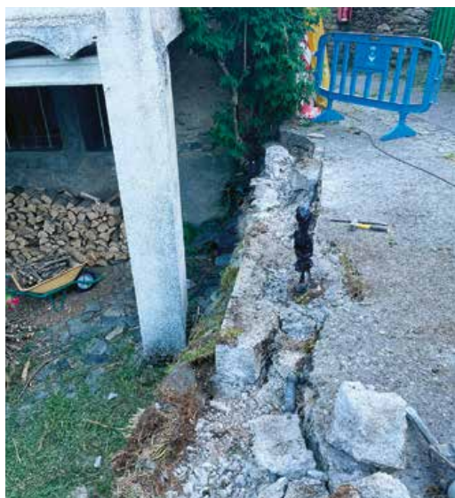
Execució de mur escullera i tanca metàl·lica a les naus de la brigada d'Empalau
